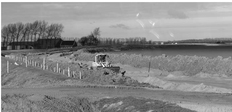
FIGUUR 3. AANLEG VAN DE NIEUWE SLOELIJN
